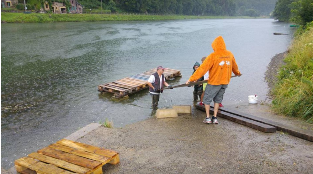
Construction d'un ponton du type « Lada » avant notre arrivée
